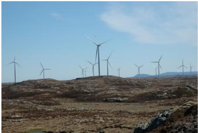
Statkraft Energin Smøla-tuulipuisto
