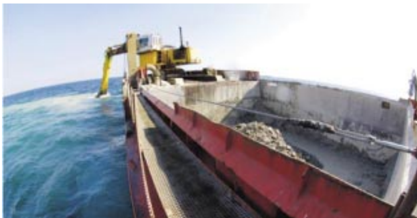
Vattenfallin uutta puistoa ruvettiin rakentamaan Lillgrundetille huhtikuussa. Tässä ruopataan merenpohjaa perustoja varten.
