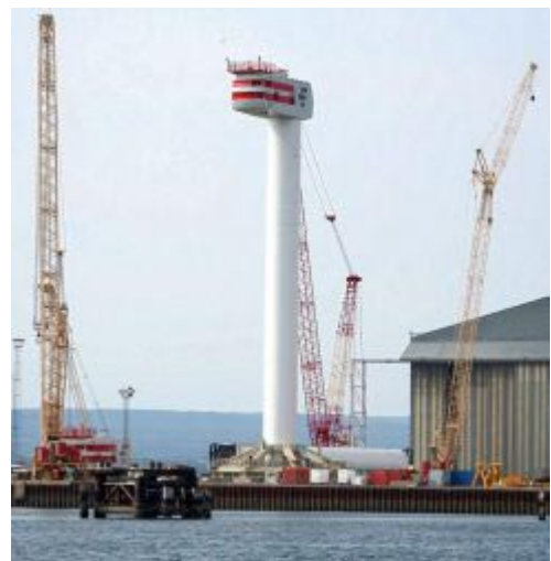
Jättimylly norjalaisella tornilla asennettavaksi 45 metrin syvyyteen Skotlannin rannikon edustalle.
