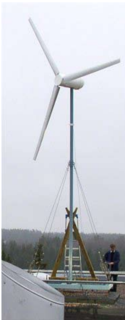
Tuulivoimala pystytysvaiheessa.
