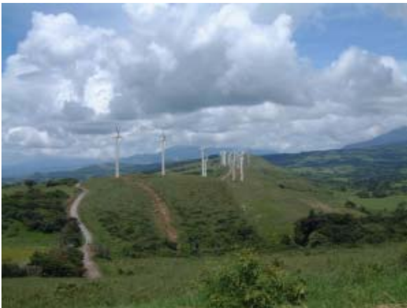
Kuva 1. Tejonan tuulivoimala Costan Rican vuoristossa.
