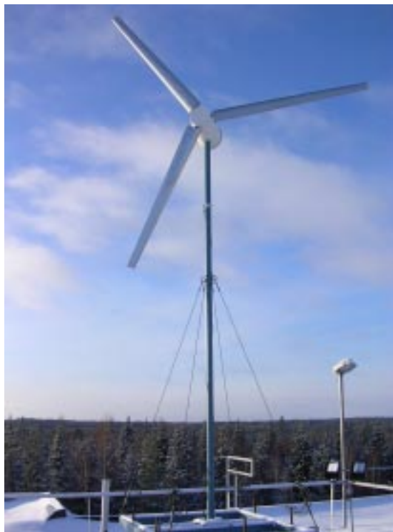
Kuva 1. 1,6 kW:n prototyyppi asennettuna Lappeenrannan teknillisen yliopiston katolle.
