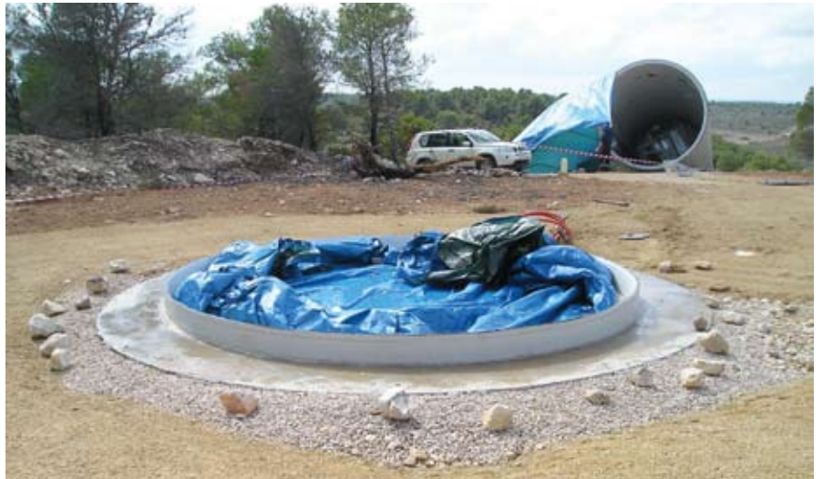
Tornin katkeaminen hitsausliitoksesta. 1,5 MW:n tuuliturbiini kaatumisen vuoksi koko tuulipuiston tuotanto oli pysäytetty, kunnes hitsausvirhe oli selvitetty.
